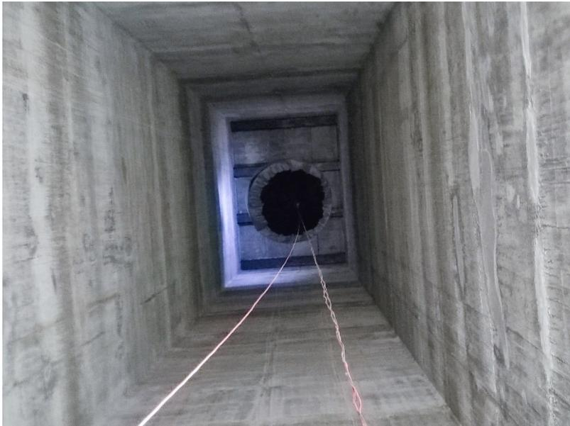
Im April 2025 durften wir im Auftrag der Hamburg Port Authority (HPA) die Bauwerksprüfung der Köhlbrandbrücke Hamburg in den beiden Strompfeilern, insbesondere der Deckenunterseiten mit den Bauprüfern des HPA durchführen. Bisher wurden die 6 Kammern der beiden Strompfeiler in die Tiefe wie in die Höhe zeit sowie personalintensiv eingerüstet. Bei gleichem Ergebnis wurde eine hohe Einsparung erzielt, die auch Sie zukünftig nutzen können.
